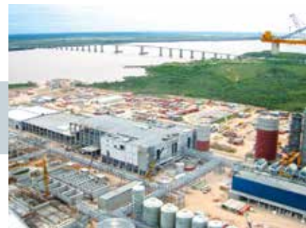
2007 Größter Montageauftrag: Papierfabrik in Uruguay
