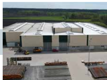
2021 Bau und Inbetriebnahme der zweiten BuBi® Fertigungslinie in Knesebeck
