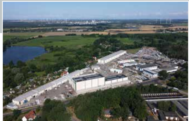
BUTTING Anlagenbau in Schwedt
